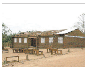
Het resultaat na bijna drie weken werk; een bijna gereed nieuw schoolgebouw.
